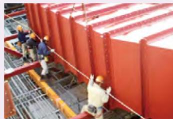
【鋼板製大型ダクトの据付工事】
