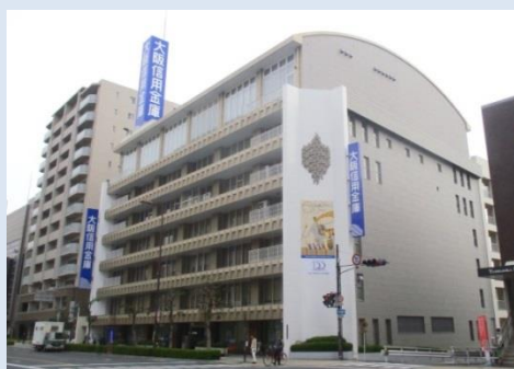
本店の外壁の様子
